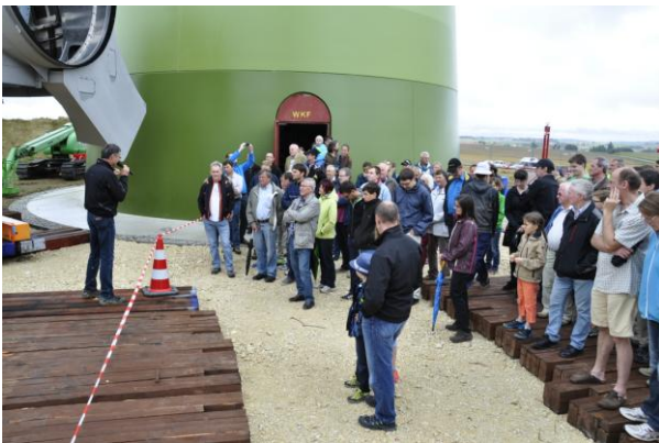
Abb.: Tag der offenen Baustelle am Bürger-Windrad
