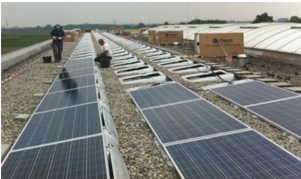
Abb.: Bau der landkreiseigenen Photovoltaikanlage auf der Realschule Eching, 2012
