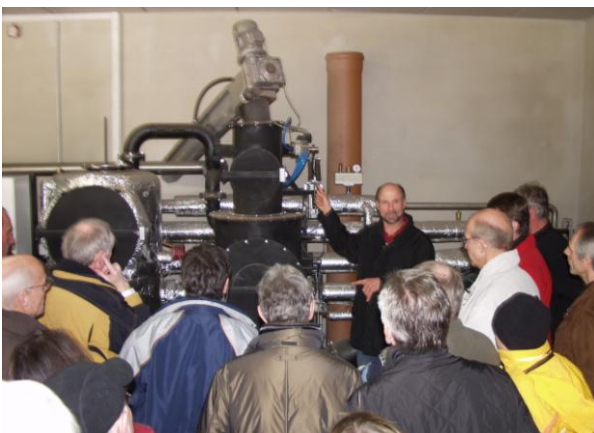
Abb.: Die innovative Holzvergaseranlage zur Strom- und Wärmeerzeugung auf dem Biolandhof Braun in Dürneck findet weltweites Interesse.
