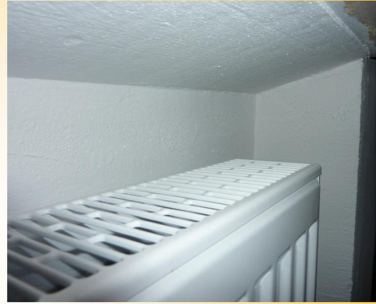
**Heizkörper neu:** Geringes Wasservolumen, reaktionsschnell, hoher Abstrahlungsanteil
