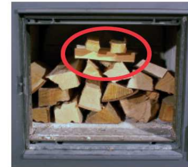
In Speicheröfen werden die Scheiter mit der Stirnseite nach vorne eingefüllt
