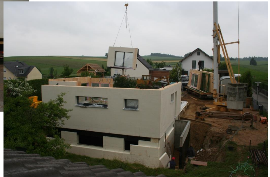
Montage der vorgefertigten Teile
