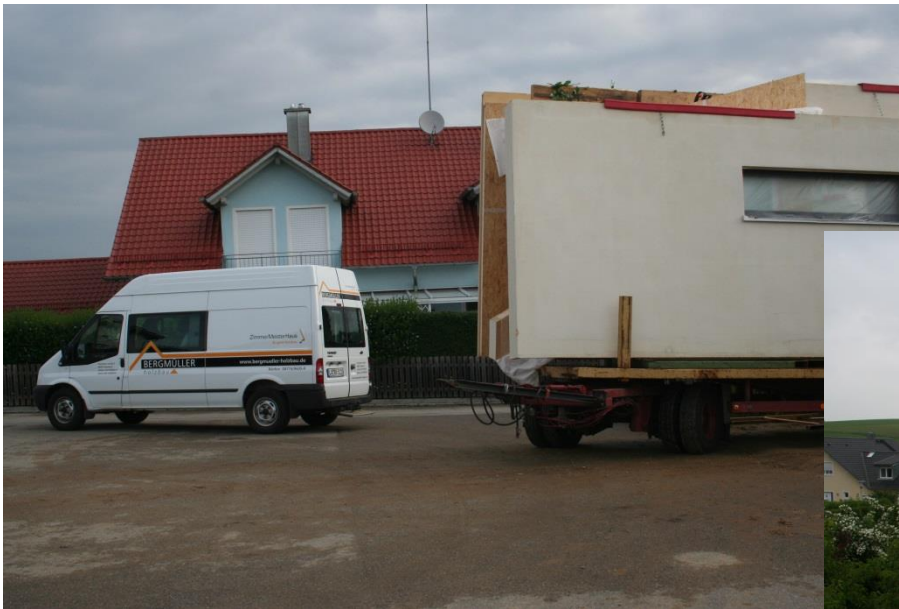
Anlieferung vorgefertigter Teile des Gebäudehülle
