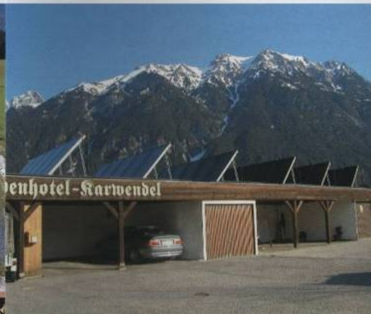
■ Bild 6: Solartechnik vor malerischer Kulisse. Die Flachkollektoren wurden mit einem Anstellwinkel von 50° montiert, um auch bei flacherem Sonne optimale Solarerträge zu erwirtschaften.
