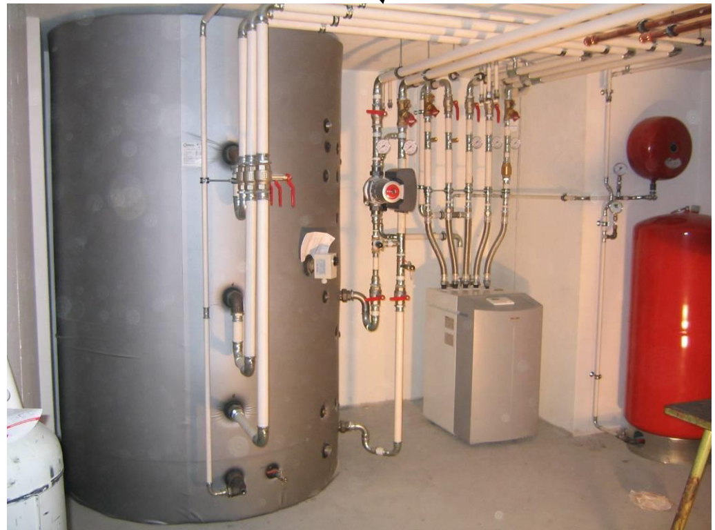
Wärmepumpe im Einfamilienhaus
