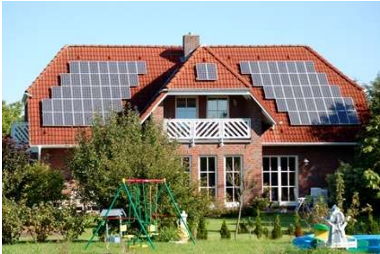
PV auf Hausdach
