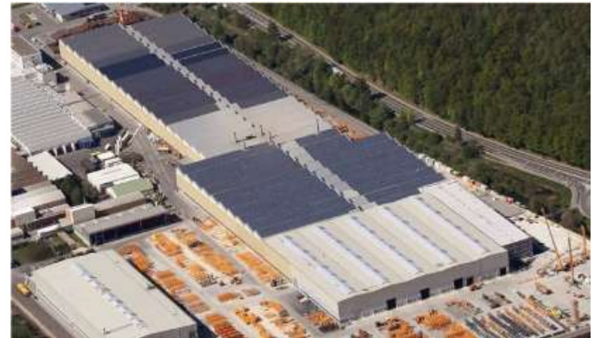
PV auf Industriedach
