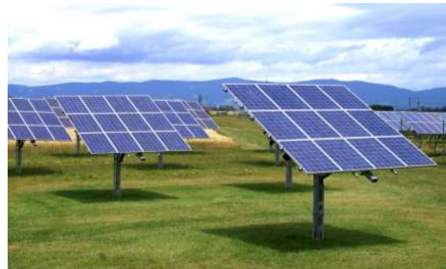
Freiflächenanlage Tracking-System
