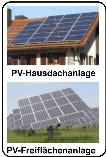
Photovoltaik-Module als Gleichstrom-Generator
