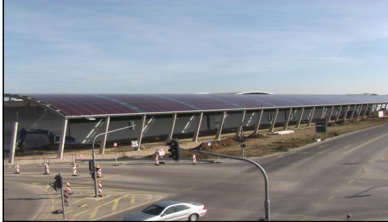
GVZ Ingolstadt: Gleißüberdachung 11.663 m 2 , 745 kWp
