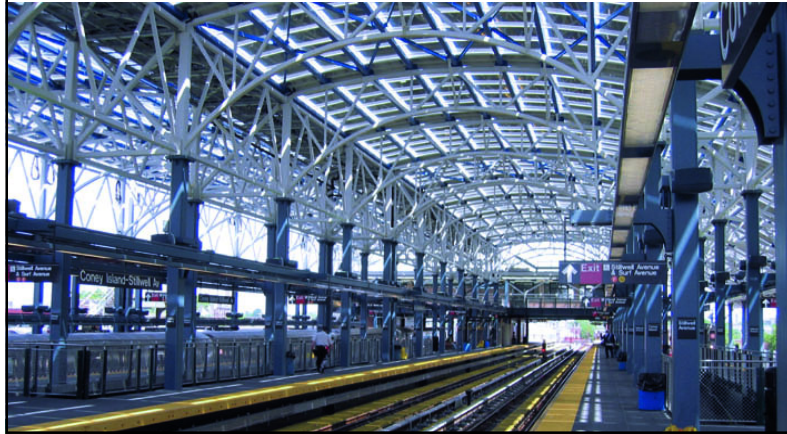
Glaswerke Arnold heute (2003): Stillwell-Bahnhof in New York weltweit zweitgrößte Anlage BIPV, 5.300 m 2 , 240 kW
